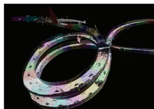
図4. 大橋ジャンクションの形状計測
