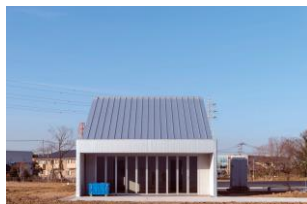
再生可能エネルギー 環境試験建屋(REハウス)
