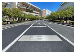
非接触給電装置
